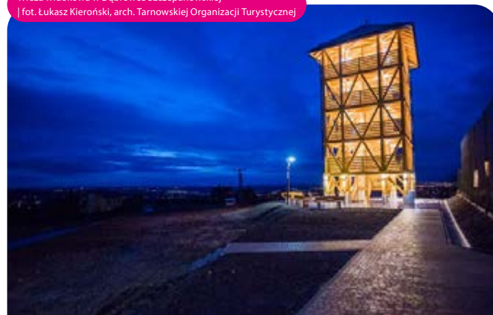
Wieża widokowa w Dąbrowce Szczepanowskiej fot. Lukasz Kieroński, arch. Tarnowskiej Organizacji Turystycznej
