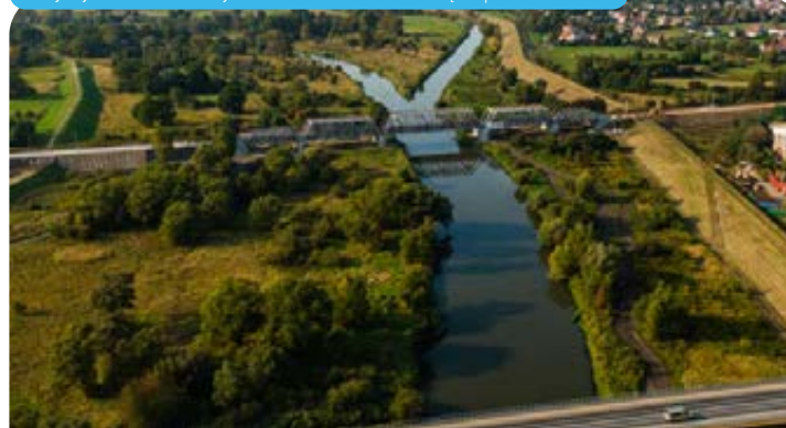
Kolejowy most kratownicowy na Wiśle i linia Trzebinia – Oświęcim | fot. Kamil Sorocki
